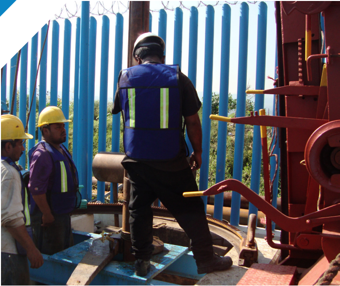
Equipo de bombeo
